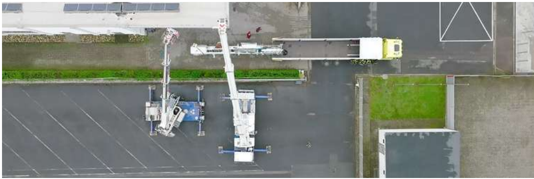
Seit Monaten werden die neuen Maschinen Stück für Stück angeliefert und aufgebaut – hier die Kanten- und Formatzelle.
