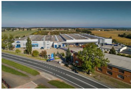
Für unser hochmodernes Werk in Stolno wurde das Nachbargrundstück als Landreserve erworben.
